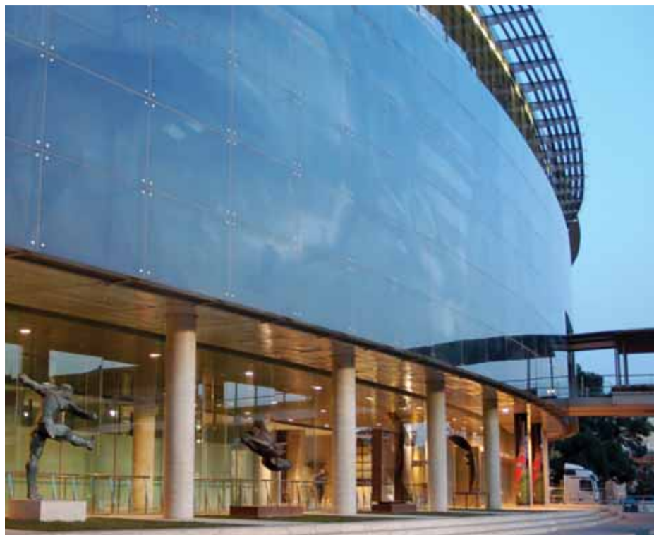
Façana de l'estadi, després de la remodelació del 1997.
