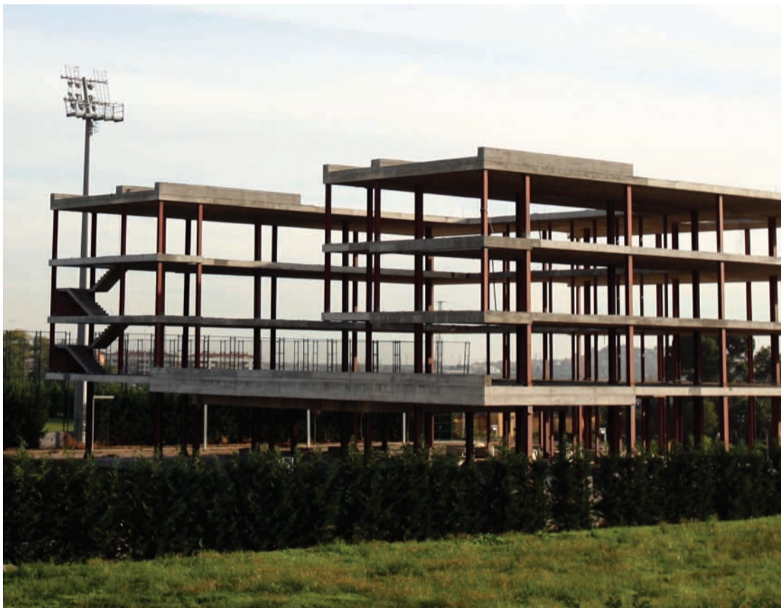
Imatge de l'estructura ja existent, a partir de la qual es construirà la residència a la Ciutat Esportiva.
