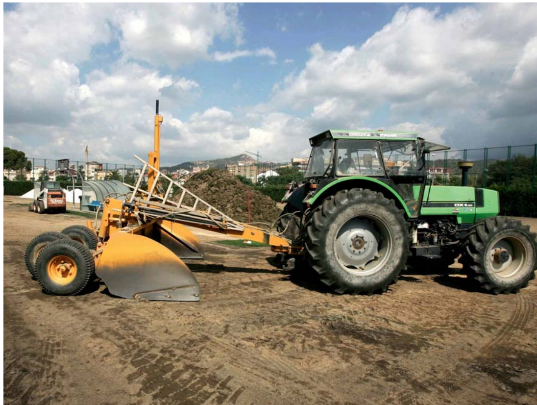
La setmana passada ja van començar les obres per canviar la gespa del camp 1 per posar-hi la mateixa que hi ha al Camp Nou. FCB
